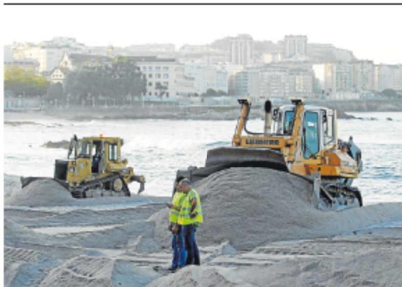
Las máquinas se moverán 23.300 metros cúbicos de arena para levantar la protección
